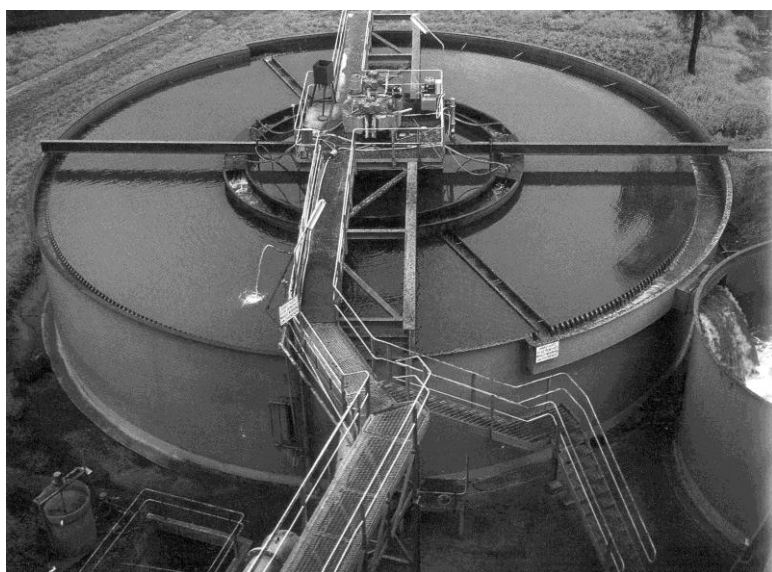
Рис. 11.2. Общий вид радиального сгустителя
