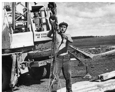
Фото 2. На монтаже коровника. Кормиловская ПМК. 1974 год. Стройотряд ОмСТ «Изот-2». Фото Николая Денисова
