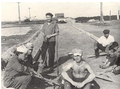
Фото 1. Стройотряд ОмСТ на строительстве Камского автозавода. 1970 год. Фото из архива Екатерины Горбуновой
