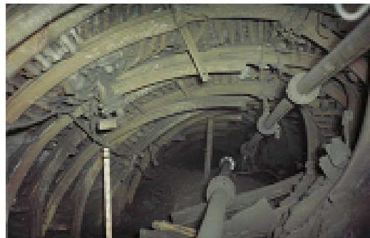
Рисунок 2 – Общее состояние вентиляционного ходка 4-восточной лавы пласта с 11 без крепи усиления на расстоянии 60 м (а) и 120 м (б) вслед за лавой
