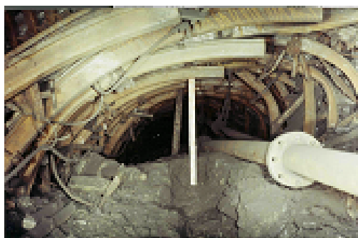
Рисунок 2 – Общее состояние вентиляционного ходка 4-восточной лавы пласта с 11 без крепи усиления на расстоянии 60 м (а) и 120 м (б) вслед за лавой
