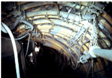
Рисунок 9 – Состояние конвейерного штрека с продольно-балочной крепью усиления в проходческом забое (а) и вслед за лавой на расстоянии соответственно: б) – 60 м; в) – 80 м (при отсутствии крепи усиления на локальном участке); г) – 120 м за (при подрывке почвы)
