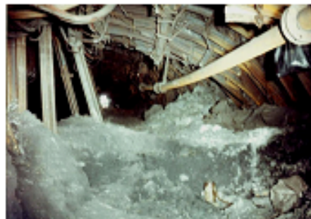
Рисунок 9 – Состояние конвейерного штрека с продольно-балочной крепью усиления в проходческом забое (а) и вслед за лавой на расстоянии соответственно: б) – 60 м; в) – 80 м (при отсутствии крепи усиления на локальном участке); г) – 120 м за (при подрывке почвы)
