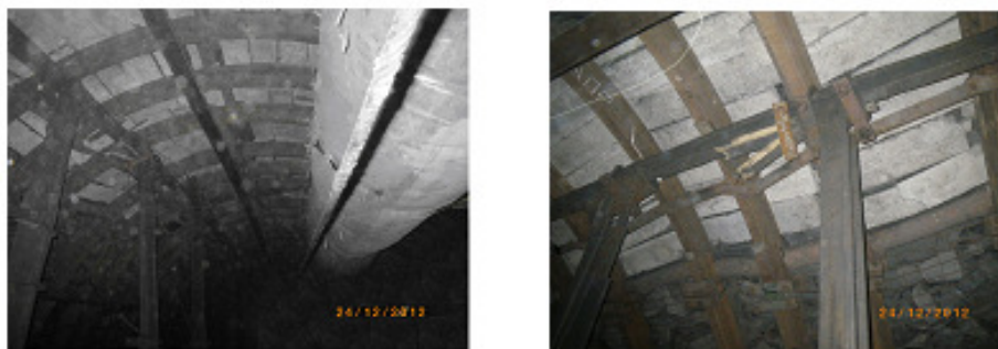
Рис. 1 - Состояние штрека при использовании продольно-балочной крепи усиления
