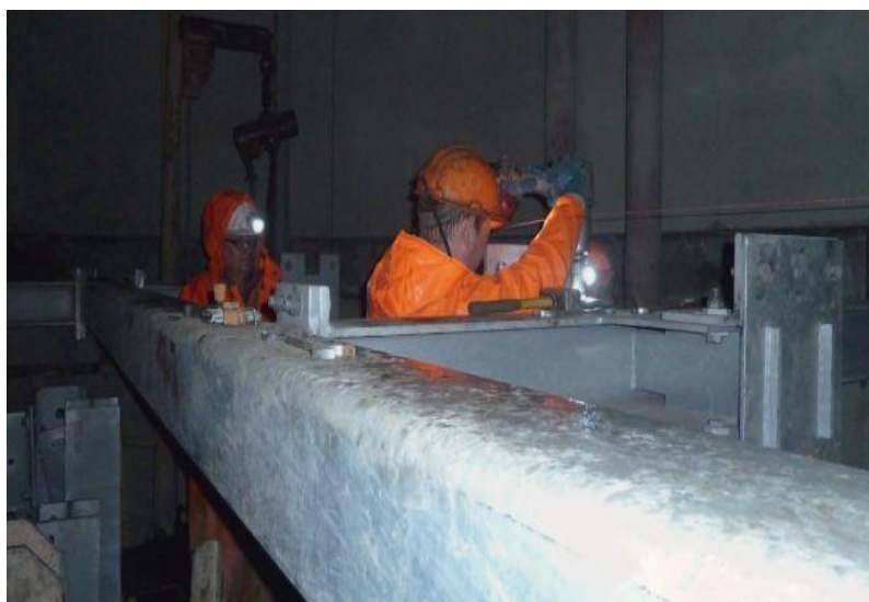
Рис.5. - Монтаж элементов армировки ствола с верхнего этажа полка.
