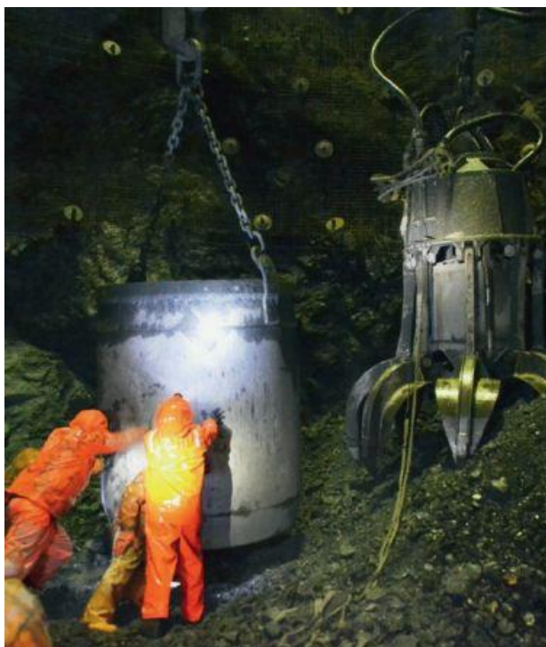
Рис.2. - Погрузка породы в забое ствола.
