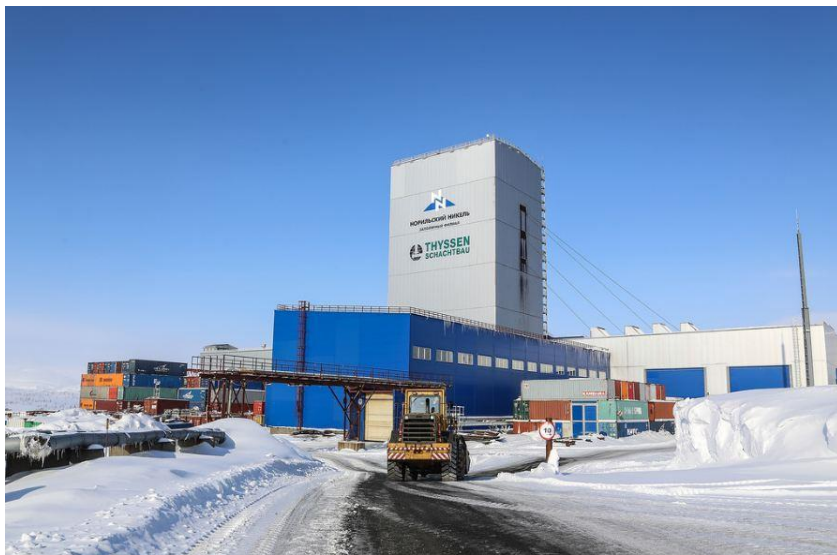
Рис.1. - Общий вид строительной площадки ствола ВС-10.
