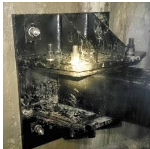
Рис.1. - Конструкция опорного кронштейна крепления концов расстрела анкерами.
