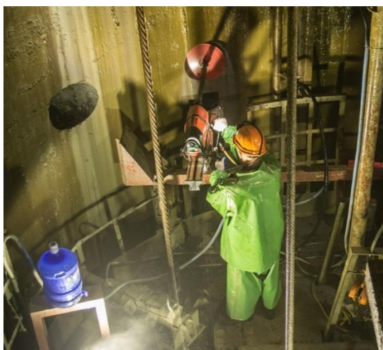
Рис.3. - Бурение лунок установкой DD-350-CA фирмы HILTI
