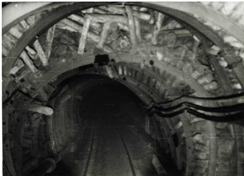
Рис. 2 – Состояние западного коренного откаточного штрека пласта h_7 горизонта 758 м шахты им. М.И. Калинина ГП "ДУЭК" к моменту начала ремонта
