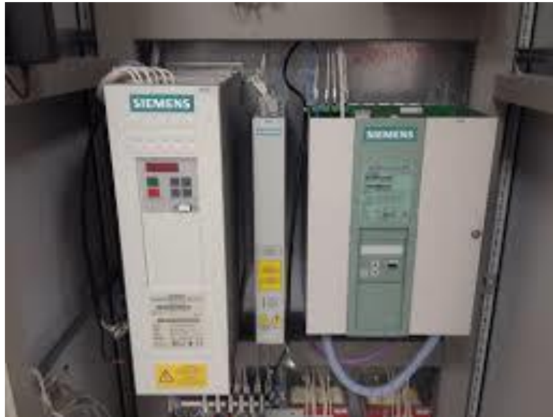
Рисунок 1 — Общий вид частотного преобразователя фирмы Siemens
