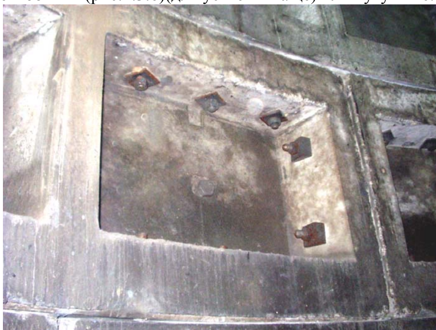
Рис. 2.3.6. Крепь ствола из ж/б тубингов.
