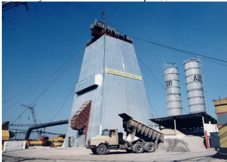
Рис.5.3. Общий вид строительной площадки ВПС №2 АП «Шахта им.Засядько» (г.Донецк).
