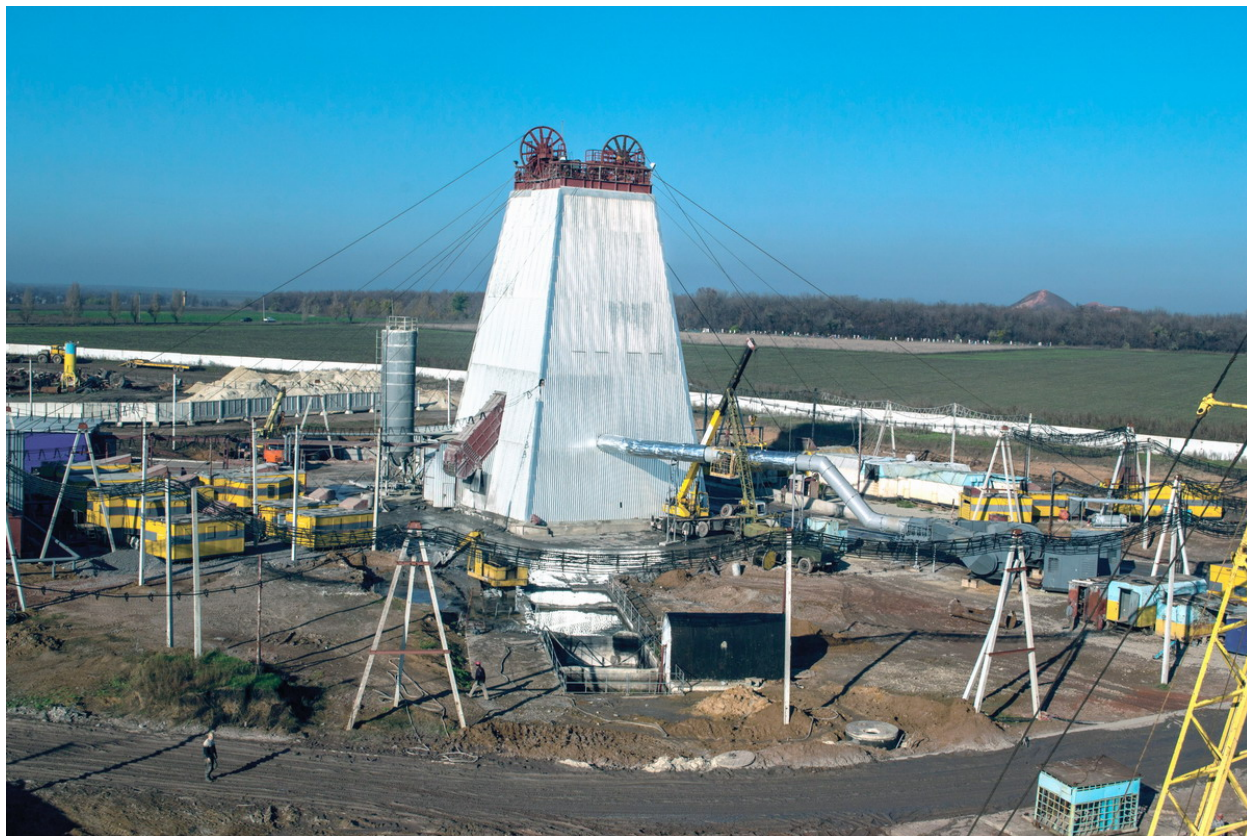
Рис.5.8. Оснащенный к проходке воздухоподающий ствол №3. Июнь 2013г.
