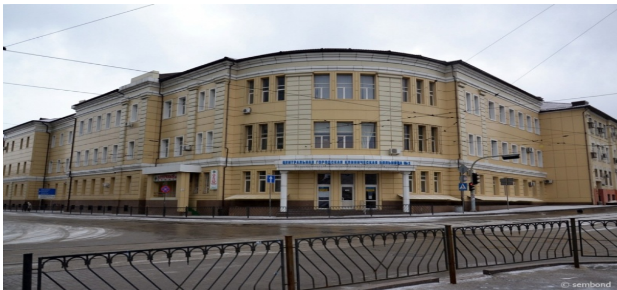
Рис.1 – Здание Городской больницы №1
