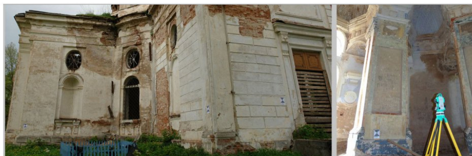
сканирование объекта с помощью лазерного сканера
