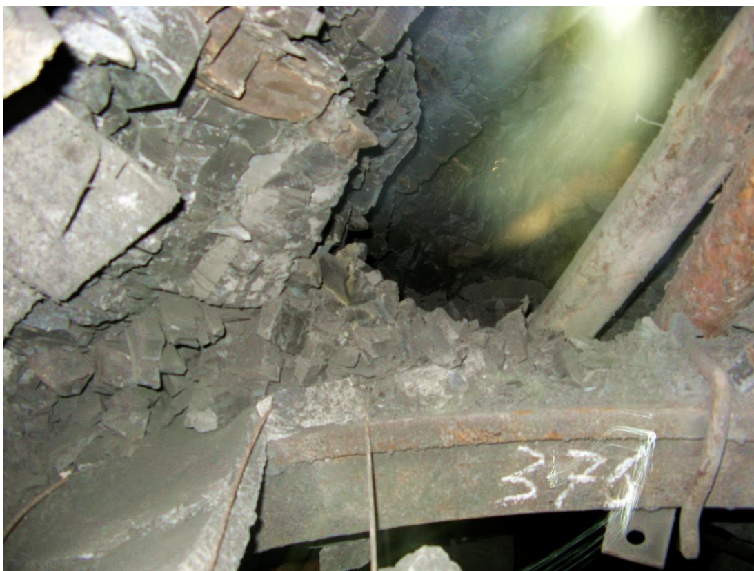
Рисунок 1.3- Общий вид купола вывала над верхняком крепи выработки
