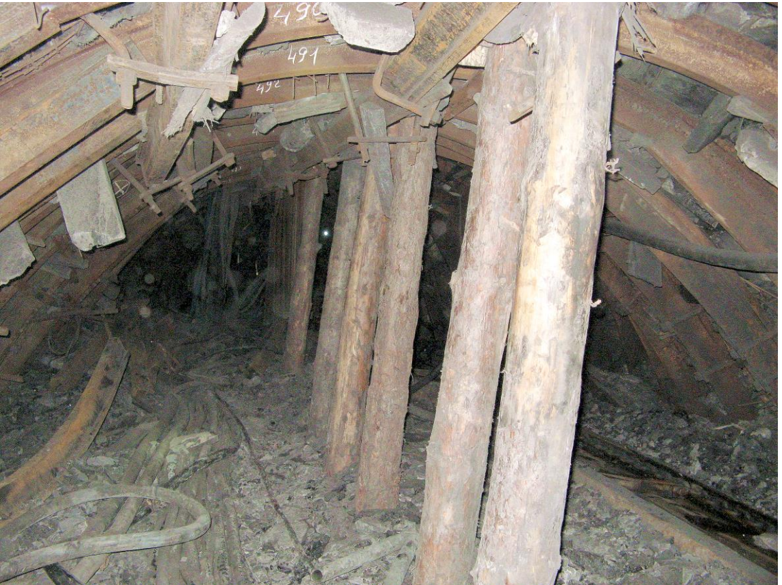
Рисунок 1.6 – Общий вид выработки в непосредственной близости к очистному забою
