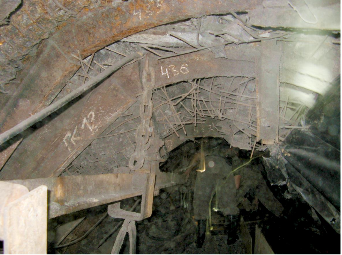
Рисунок 1.5 – Общий вид выработки на обводненном участке
