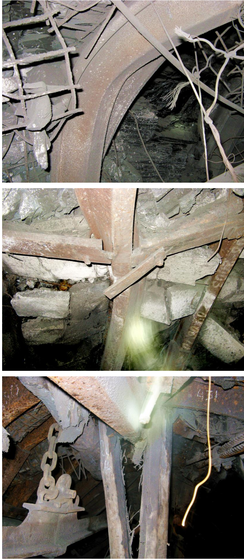
Рисунок 1.8 – Общий вид участков деформирования элементов крепи выработки
