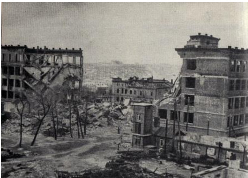
Пятый учебный корпус, разрушенный фашистскими захватчиками
