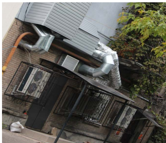
Рисунок 2 – Расположение вентиляторов на входе в жилой подъезд
