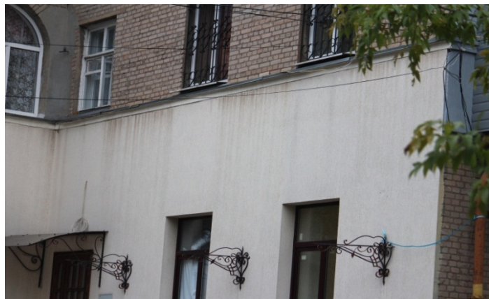
Рисунок 1 – Последствия влияния выбросов на внешний вид здания
