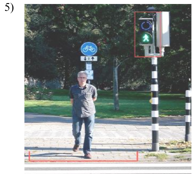
Рисунок 1.15 – Монтаж детектора пішоходів на підході до пішохідного переходу
