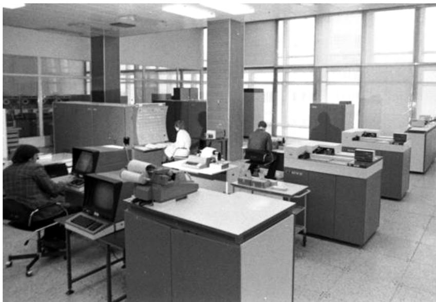
Рис. 2. 1980 год: самый мощный советский компьютер ЕС-1060, интенсивно эксплуатировавшийся в ДонНТУ с начала 80-х до начала 90-х годов: производительность 1 Мфлопс, потребляемая мощность 60 КВт, для охлаждения были установлены 2 шахтных вентилятора мощностью по 40 КВт (1 рабочий и 1 резервный), суммарная потребляемая мощность составляла 100 КВт.
