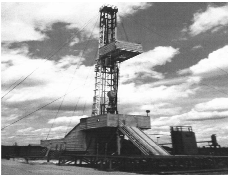
Рисунок 6 – Установка бурового станка
