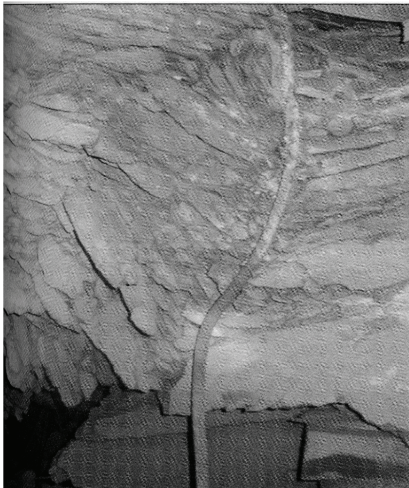
Рис. 17. Характер изгиба стадеполимерного анкера в кровле выработки
