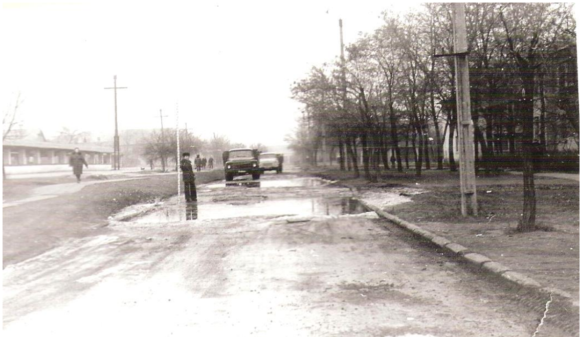
Рис.1 – Рух транспорту по проїзній частині з уступами, заповненими водою
