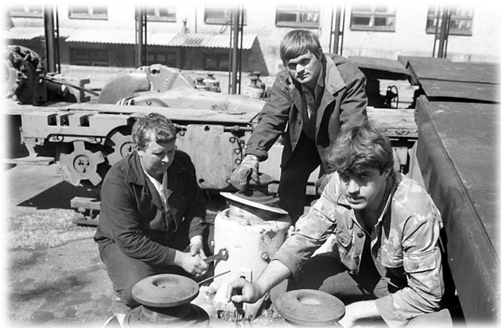
Робочі тресту «Красноармійськвугілля» монтують обладнання на навчальному полігоні
