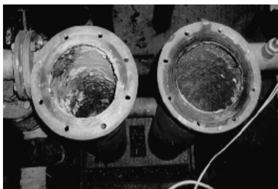
Рис.2. Отложения в антинакипном аппарате.
