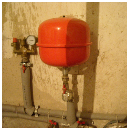
Рисунок 3 – Бак - компенсатор
