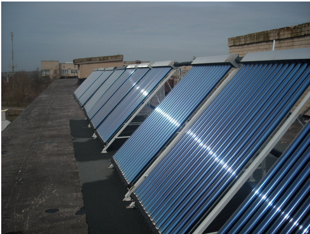
Рисунок 1 - Вакуумні сонячні колектори на даху бюджетної установи міста
