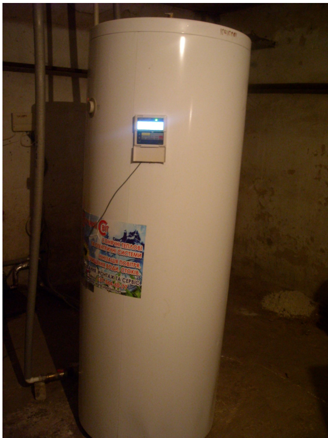
Рисунок 2 - Бак-теплообмінник
