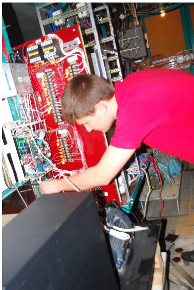
В лаборатории систем управления электроприводами 8.113. Магистрант А. Шерстюк выполняет монтаж оборудования.
