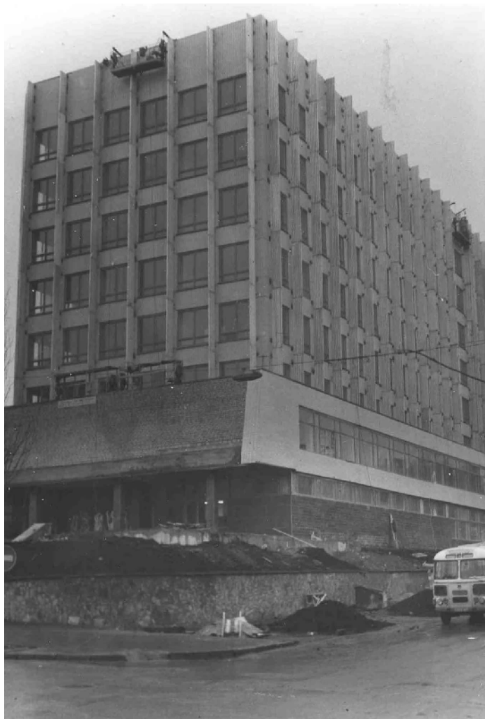
Строительство нового корпуса закончено.
