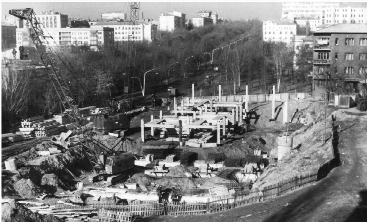
Начало строительства 8-го корпуса.
