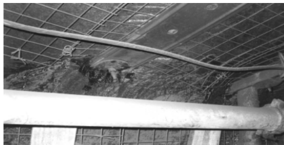
Рис.11. Выдавливание верхней угольной пакки в месте крепления подхвата у стенки выработки
