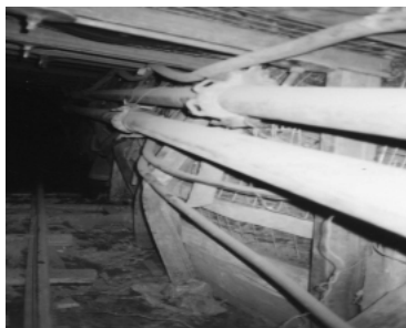
Рис.10. Характерные деформации боковых элементов крепи в выработке
