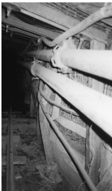
Рис. 8 – Характерные деформации боковых элементов крепи в выработке
