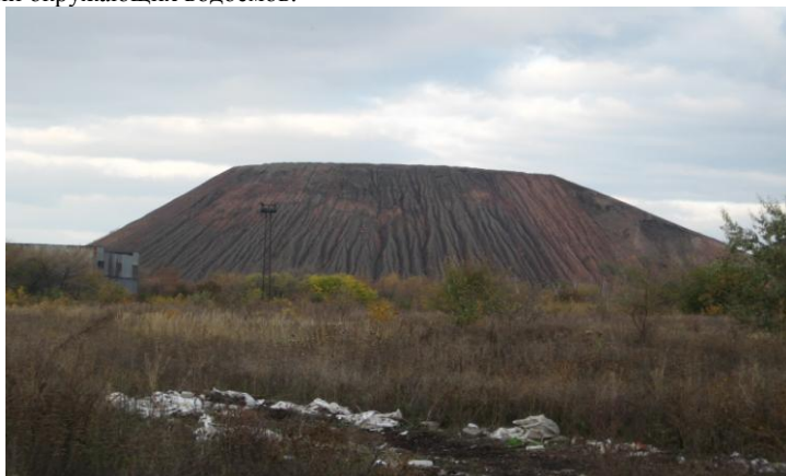
Рисунок 1 – Конический отвал без террас
