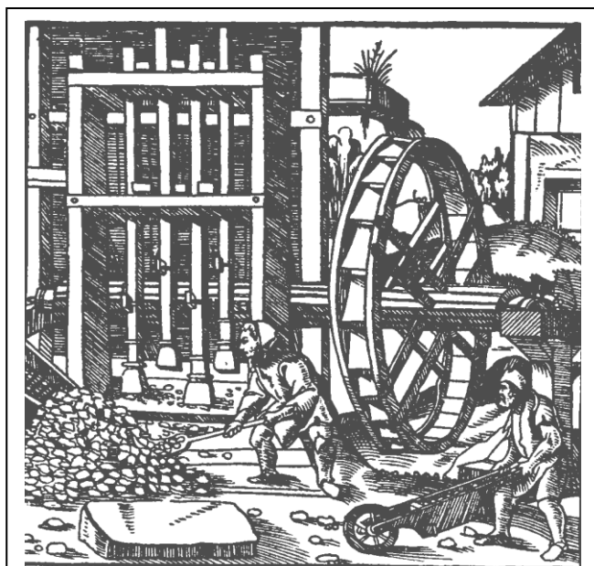
Рис. 1.1 Дробление руды в толчее (Г. Агрикола, 1556 г.)
